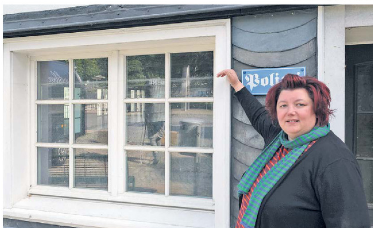
Fluthilfe-Koordinatorin Stephanie Kalter zeigt am leer stehenden Gebäude der Sparkasse in Solingen-Burg, bis wohin der Wasserstand während der Flutkatastrophe reichte. (Fotos: Schoon)
